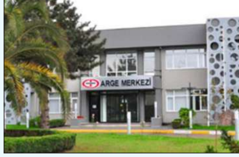
Proje: Erdemir Ereğli Ar-Ge Merkezi Ham Su Kaynağı: Proses Suyu Sistem: Filtrasyon
