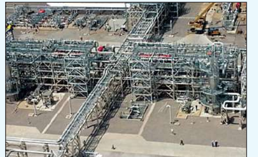
Proje: Türkmenistan İşçi Kampı Projesi Ham Su Kaynağı: Deniz Suyu ve Atık Su Sistem: MBR, RO, Filtrasyon, Dozaj
