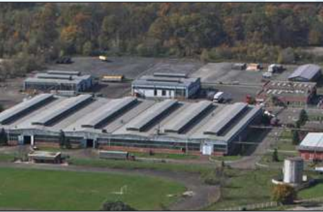
Proje: Kraljevo Tekstil Fabrikası Ham Su Kaynağı: Şebeke Su Sistem: Filtrasyon
