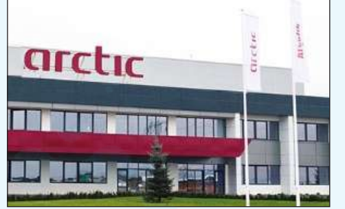
Proje: Arctic SA Romanya Fabrikası Ham Su Kaynağı: Atık Suyu Sistem: MBR, RO
