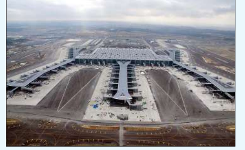
Proje: İstanbul Yeni Havalimanı Ham Su Kaynağı: Gri Su Sistem: MBR
