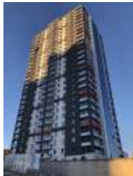
+ YENİÇERİ KULE YENİKAR İNŞAAT
