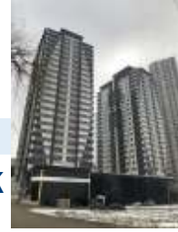
+ OVA LIFE MZB İNŞAAT
