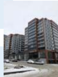
BOSPHORUS RESİDENCE + 1. ETAP ONALTIN İNŞAAT
